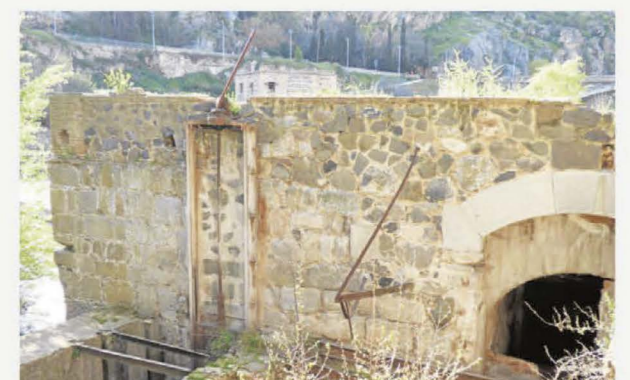
Compuerta del canal de carga (1869) y, a la derecha, arco del canal de la turbina (1893) sobre los sillares que sustentaban el Artificio de Juanelo
