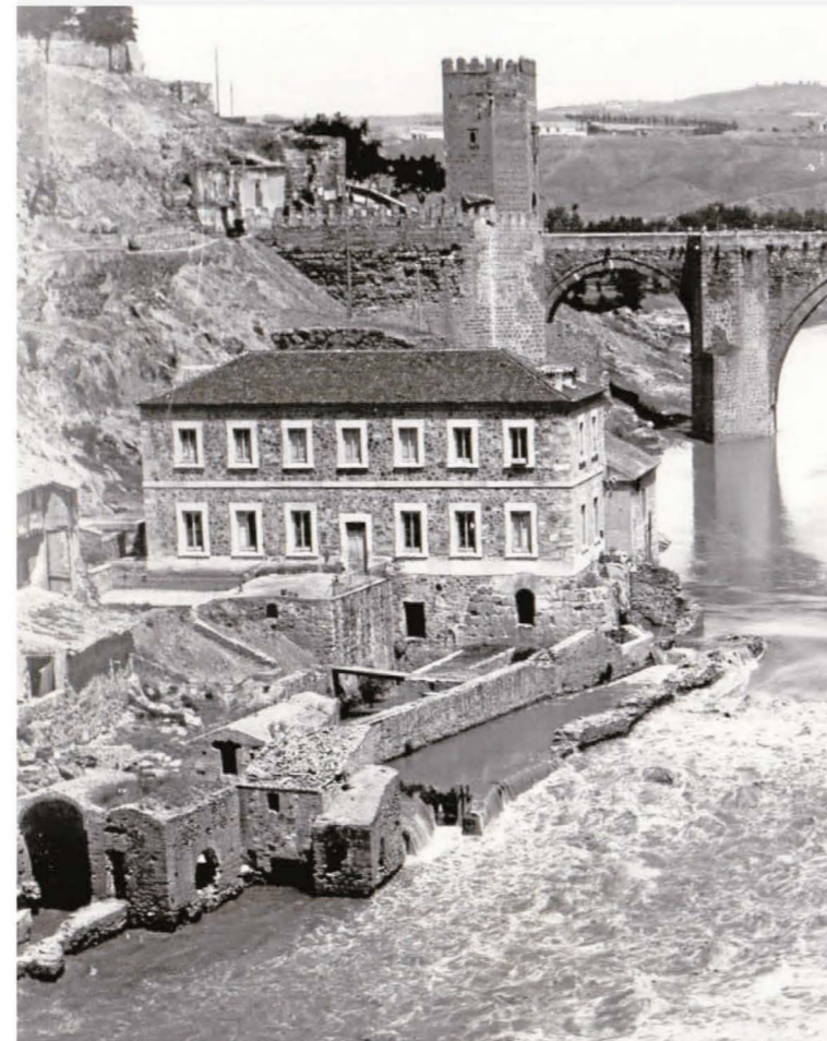
Fachada sur de la Elevadora y restos de los antiguos molinos del Artificio hacia 1912. Foto de Rodríguez. Colección particular
