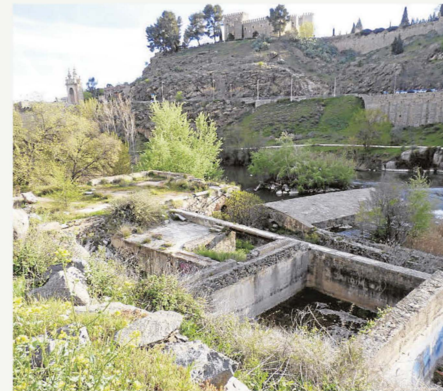
Aspecto de las balsas de decantación y del solar que ocupó la Casa Elevadora hasta su derribo en enero de 1999
