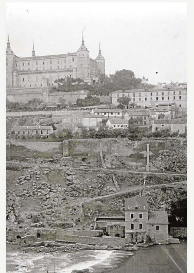
Presa del Artificio y la Casa Elevadora, hacia 1917, con los dos conductos ascendentes hacia la muralla del Carmen. A la izquierda, el de 1870 y, a la derecha el de 1915
