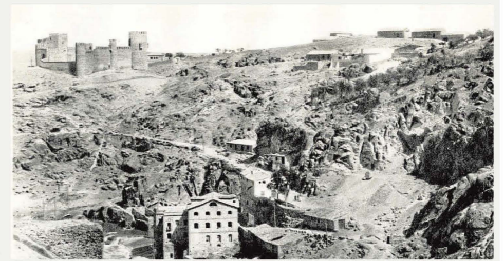
Obras para abrir una carretera sobre la presa del Artificio hacia 1930. Abajo, junto a la fábrica de harinas (1864), el edificio de la central eléctrica añadida en 1897. Foto Aldus. Archivo Municipal de Toledo
