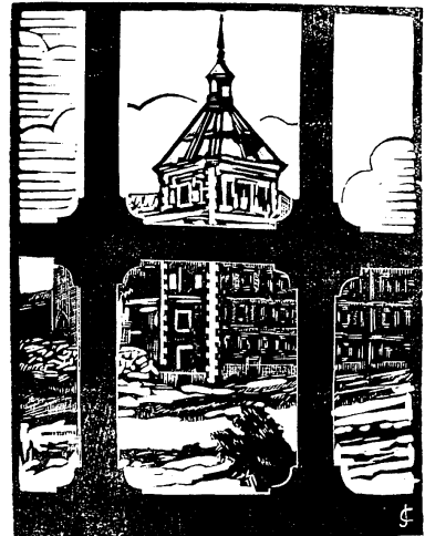
Desde el Hospital Clínico, la torreta gracil de la Casa Velázquez se ofrece como mansión de lealtad y de heroísmo. En los últimos ataques estos dos edificios han aguantado con la firmeza de los soldados de España todos los intentos marxistas.
