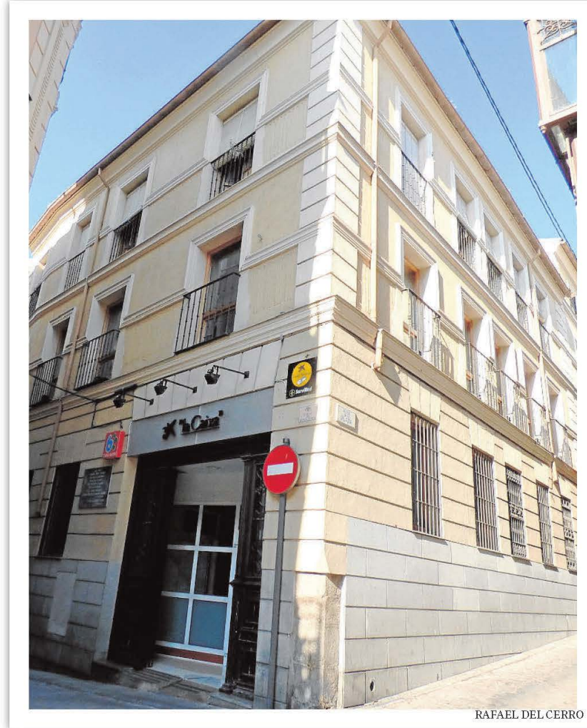
Edificio del antiguo Hotel del Lino en 2016, tras el cierre y la reforma iniciada en 1990
