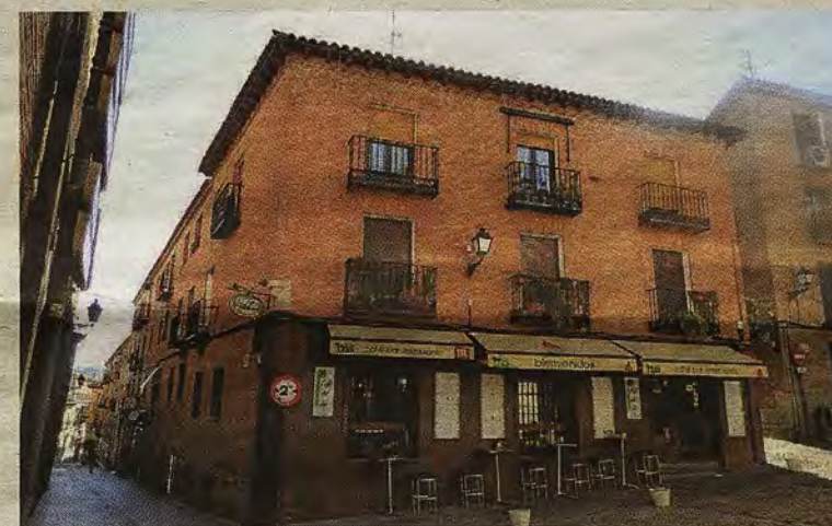
Edificio alzado en 1968 donde estuvieron las Cocheras de Alegre, antes convento de San Miguel de los Angeles.
