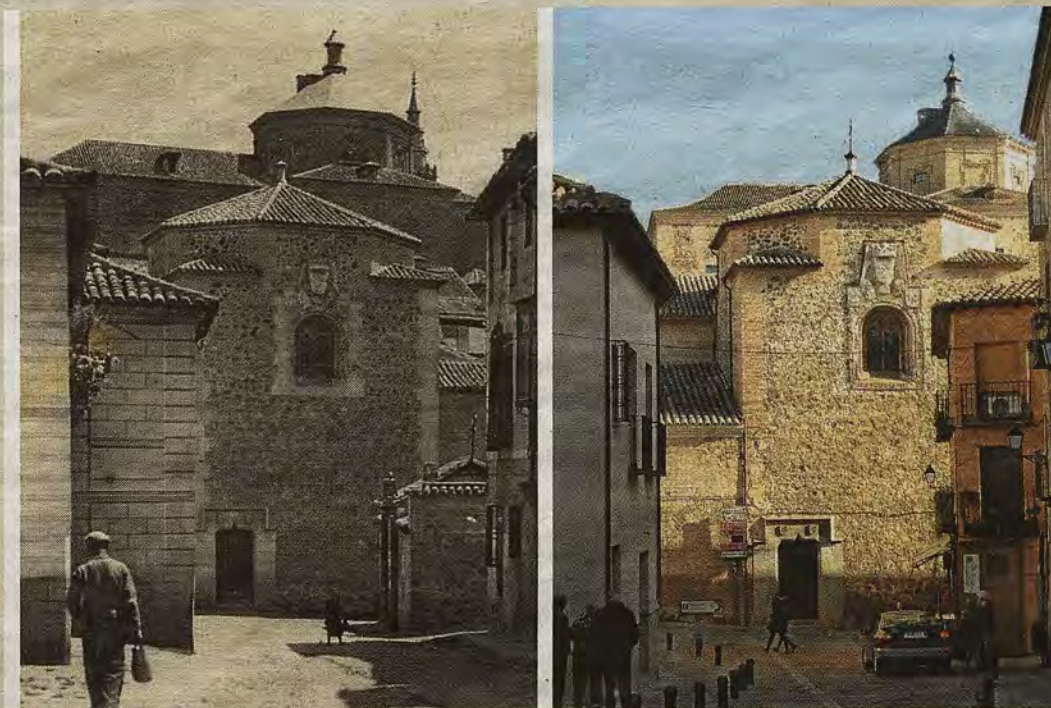
'Calle Taller del Moro en 1928 (Foto Loty). Al fondo, a la derecha, la entrada a las cocheras. La misma calle en 2018. (Foto Rafael del Cerro)
