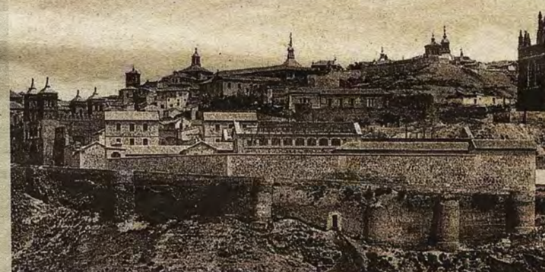
El Matadero en construcción hacia 1891 en una postal de Hauser y Menet. Archivo Municipal de Toledo
