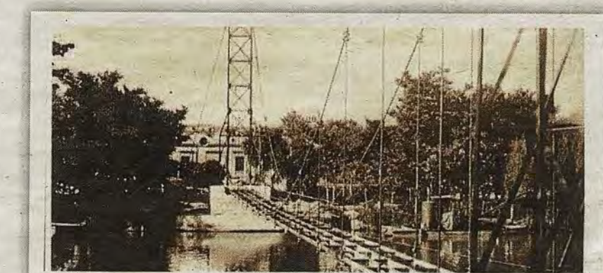
Pasarela colgante en construcción hacia 1925. Junto a la orilla, barca con la draga. Foto de José Vera. Archivo Municipal de Toledo
