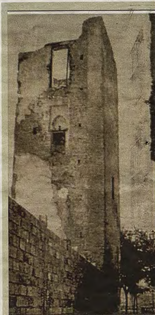
Torre arruinada y reconstruida desde el callejón de San Cristóbal. FOTOS RODRIGUEZ y RAFAEL DEL CERRO
