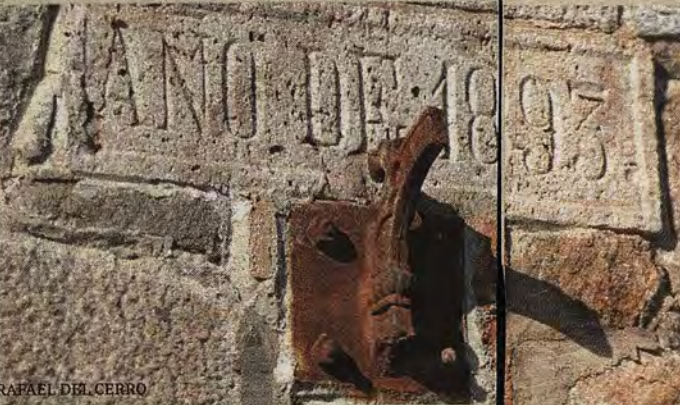
Inscripción con la fecha de 1893 alusiva a la construcción del muro
