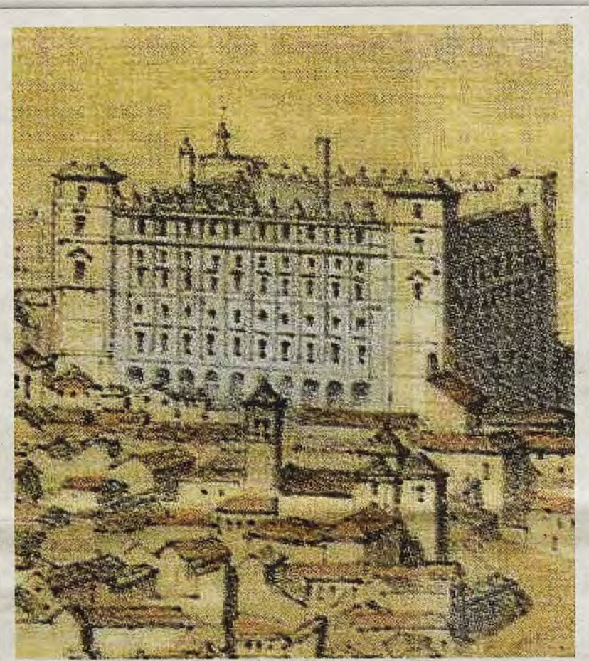
El Alcázar «a vista de pájaro» por A. Guesdon (ca. 1855). Se observan las chimeneas sobre la fachada meridional y el telégrafo óptico en el torreón NO
