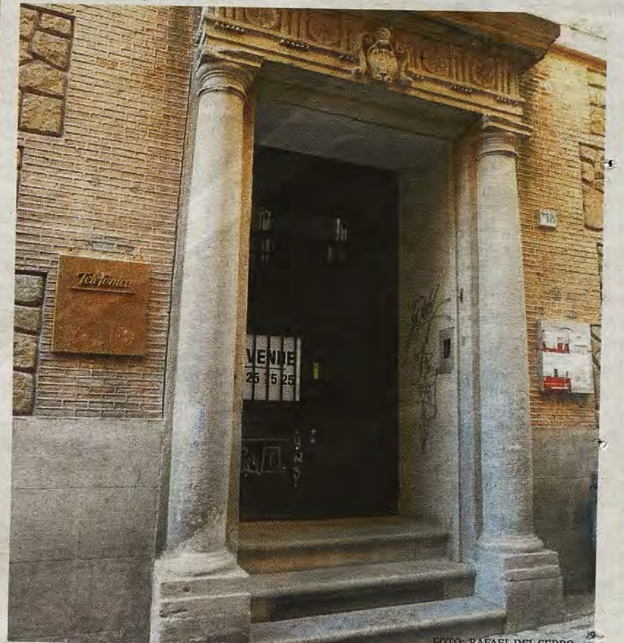
Puerta de acceso a la antigua central de teléfonos en 2011
