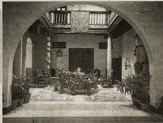
Vista del patio de la central de la calle de la Plata tras su rehabilitación en 1948. (Archivo Antonio Pareja)
