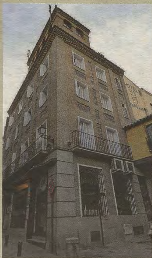
Edificio que acogió el sanatorio de San Nicolás luego convertido en alojamiento. FOTO Rafael del Cerro
