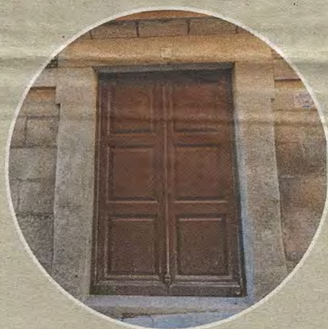
Puerta secundaria en la calle Navarro Ledesma que sirvió de acceso al refugio habilitado en la Guerra Civil. (Foto: Rafael del Cerro)
