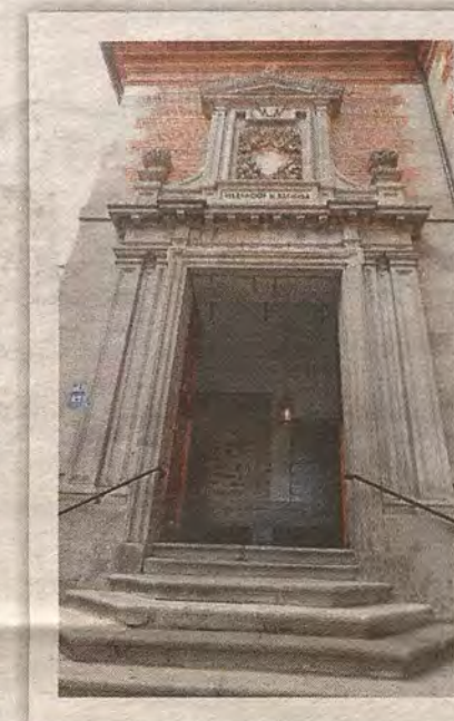
Puerta principal de la actual delegación de la Agencia Tributaria. (Rafael del Cerro)
