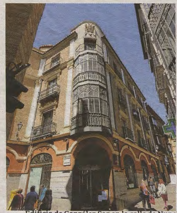
Edificio de González Saz en la calle de Nuncio Viejo 1, esquina Trinidad
