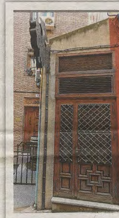
Antigua puerta de emergencia del patio de butacas del Cine Moderno. (FOTO: Rafael del Cerro)
