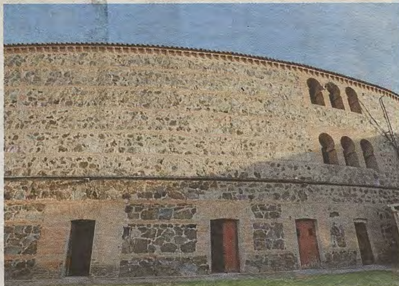
Fachada del patio de cuadrillas
