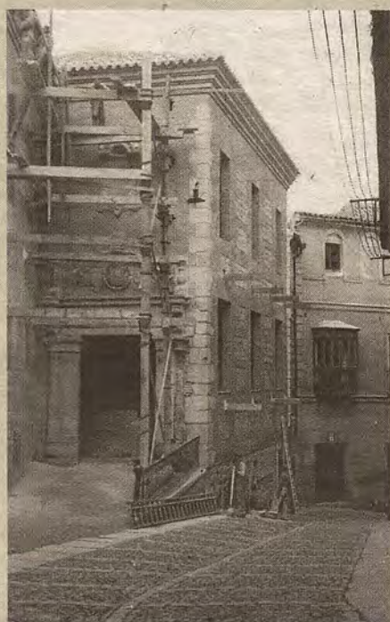
Fachada principal tras su reforma. (Foto: Colección J.L. Isabel Sánchez)
