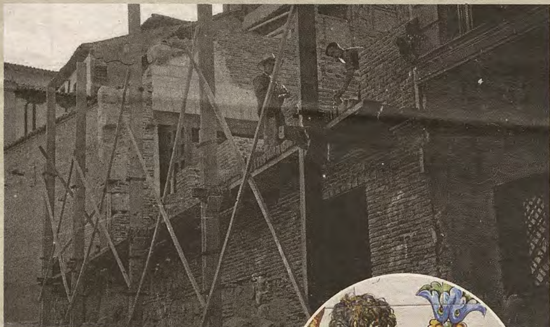
Obras en la puerta principal en 1947. (Foto: Colección J.L. Isabel Sánchez)
