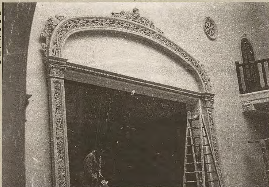
Construcción del escenario en el patio central. (Foto: Colección J.L. Isabel Sánchez)
