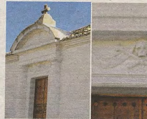
Cementerio de Ontígola, levantado en 1776
