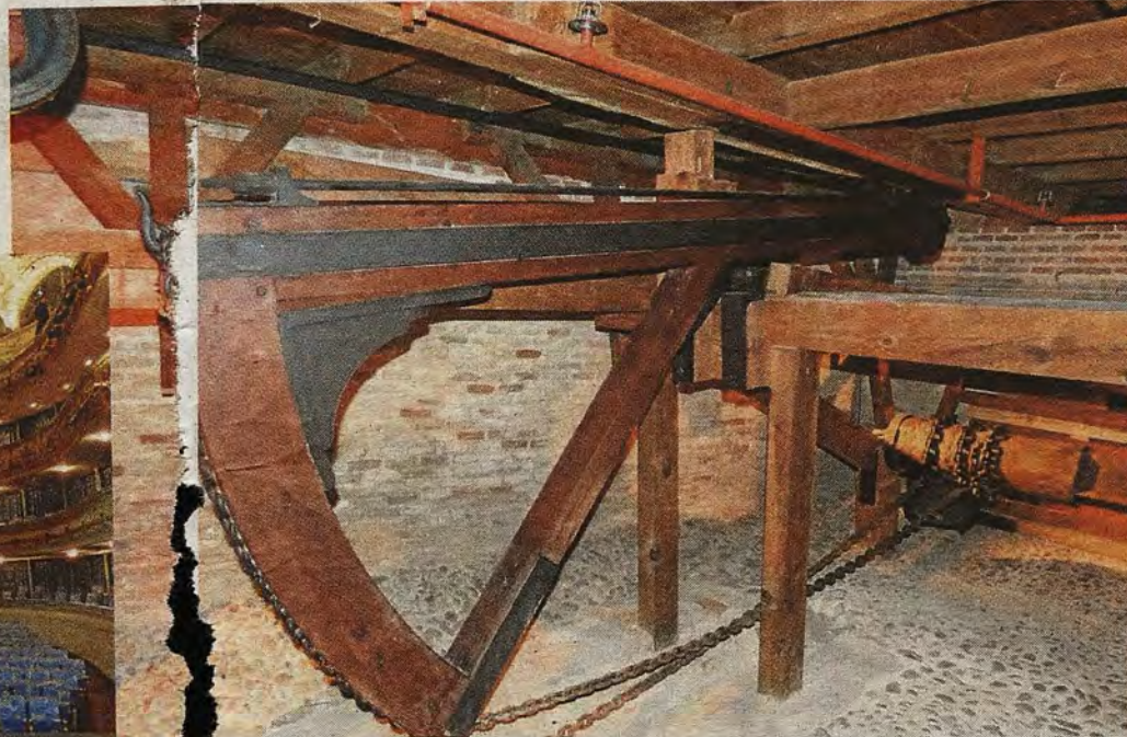
Detalle de la maquinaria para elevar el patio de butacas. Abajo, arco de embocadura del escenario. Fotos: R. DEL CERRO. A la derecha, telón de embocadura.
