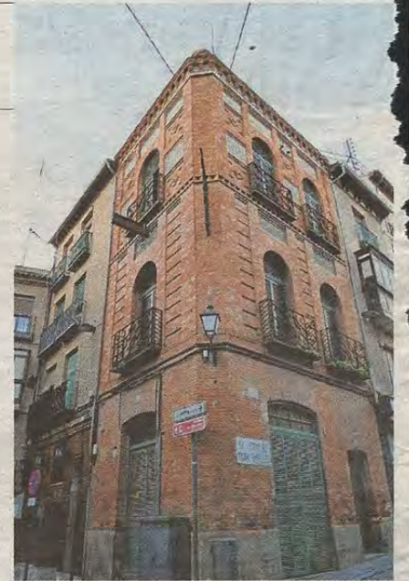
Las dos fachadas del transformador. R. DEL CERRO
