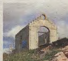
Restos de la capilla de la Venta del Hoyo. (R. del Cerro)
