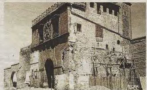
Obras del aislamiento de la puerta de Bisagra en 1934. Foto de P. Román
