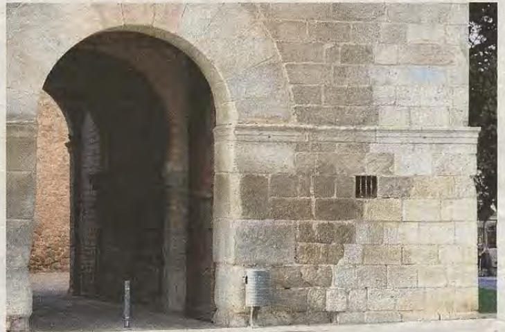
Esquina derecha rehabilitada en 1934 y ventana testigo
