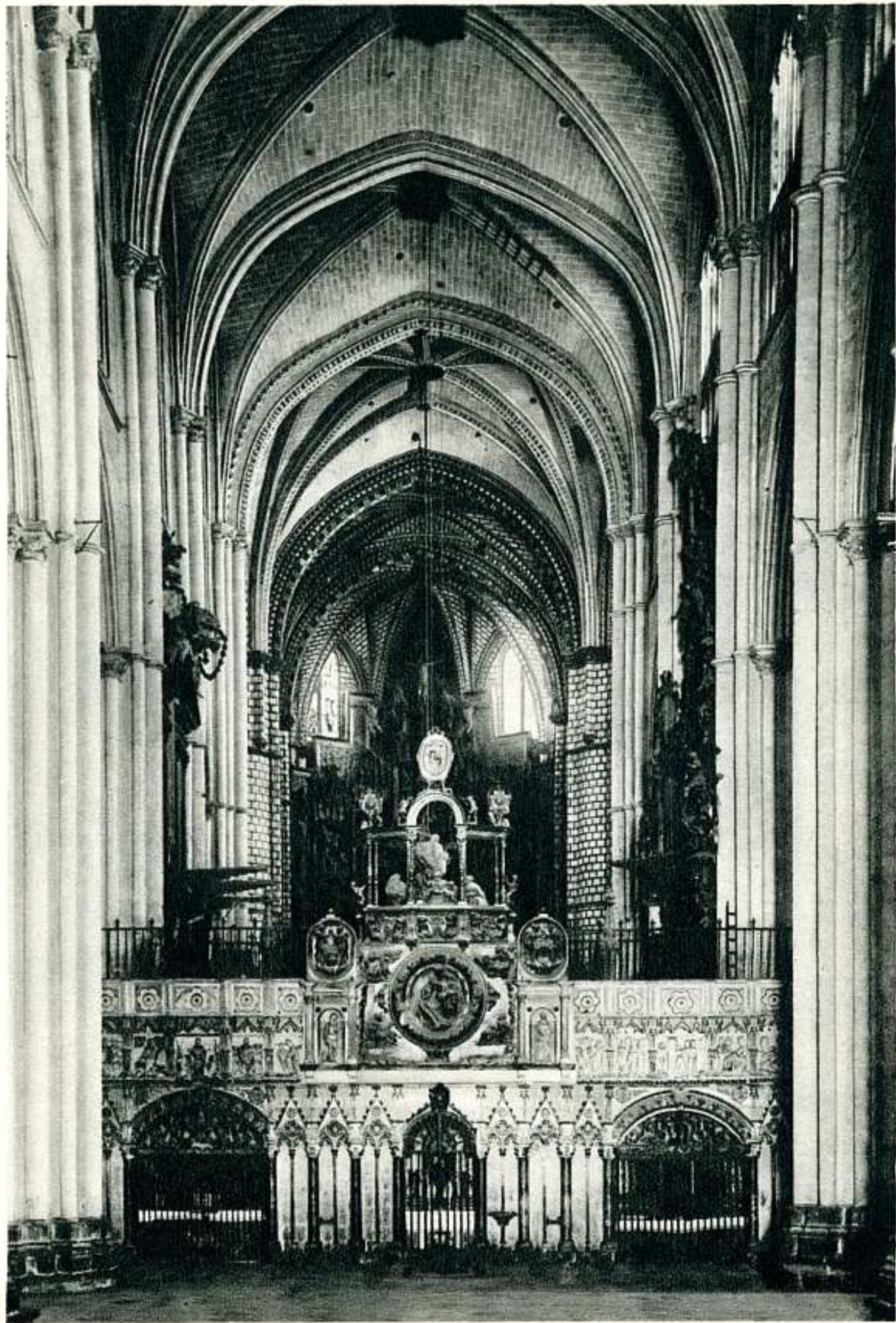
LA CATEDRAL.—VISTA GENERAL DEL INTERIOR
