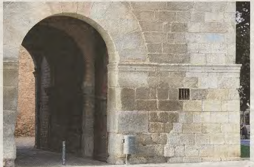
Esquina derecha rehabilitada en 1934 y ventana testigo
