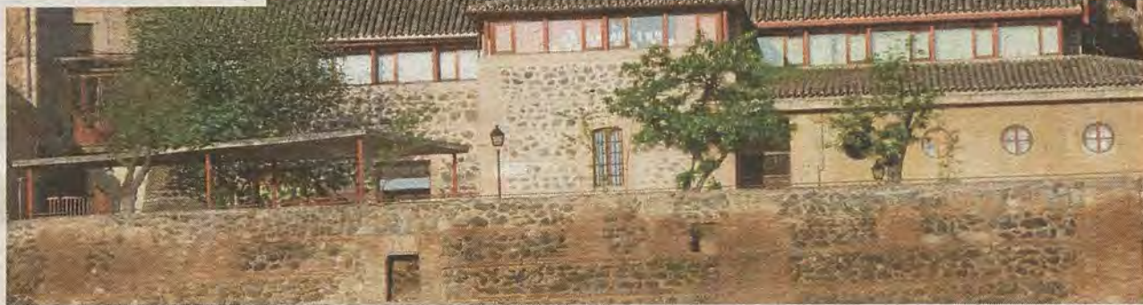
Vista general del antiguo depósito en el Paseo del Carmen en la actualidad
