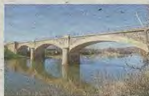
Puente ferroviario sobre el río Tajo en las inmediaciones de Toledo.
