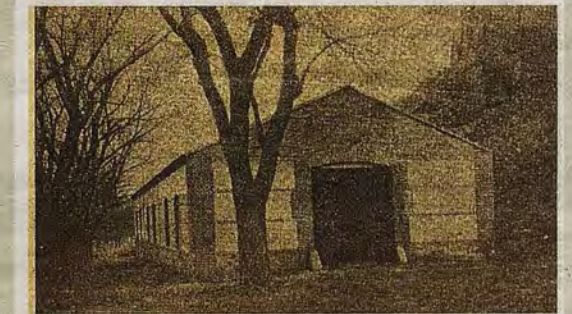
Despachos en Zocodover y en Núñez de Arce, esquina a Carretas. Garaje en el paseo de Recaredo en 1925. El Castellano . Archivo Municipal de Toledo
