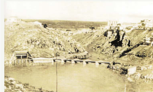
Montaje gráfico con el proyecto de una gran presa entre el cerro de la Virgen de la Cabeza y las laderas de la Judería. Foto publicada en El Toledo invisible (2002)
