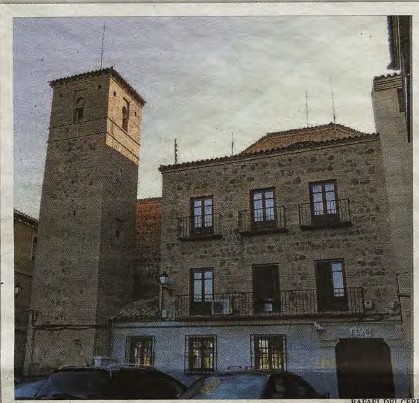
Edificio levantado en 1969 para escuela adaptado a otros usos desde 1990
