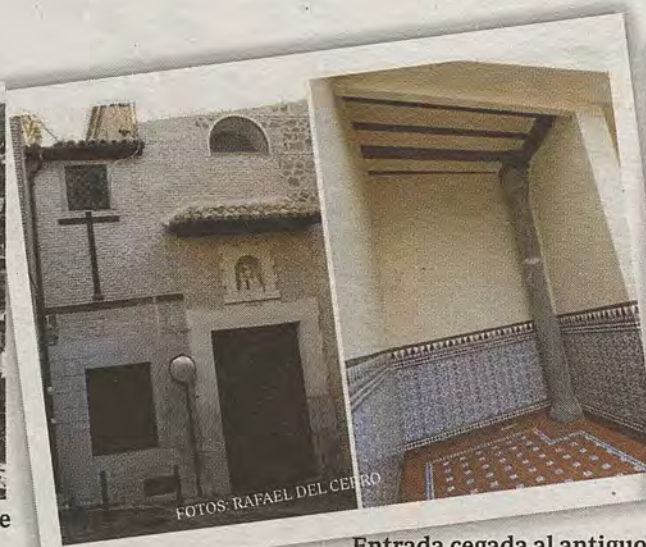
Entrada cegada al antiguo Cobertizo de las Bernardas en la calle de Núñez de Arce y restos del mismo en el interior del colegio Medalla Milagrosa
