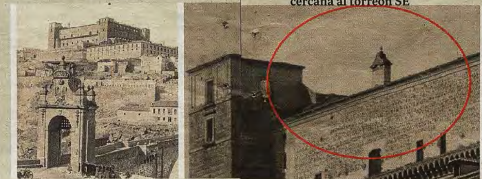
En la imagen de abajo, fotografía de Charles Clifford hacia 1858. Detalle ampliado de la chimenea cercana al torreón SE
