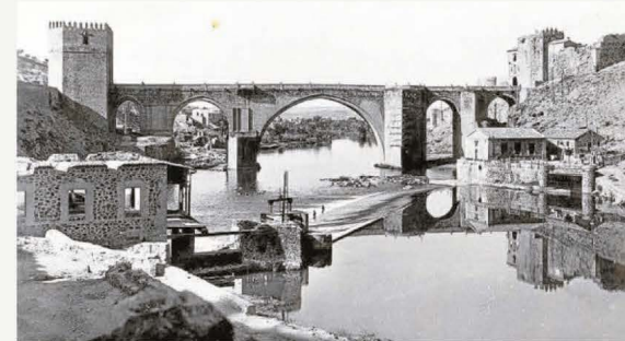
El antiguo edificio molinero de la Cruz, ya desmontado, hacia los años veinte del siglo. Imagen editada posteriormente por Manipel. Archivo Municipal de Toledo
