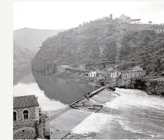
Reparación de la presa de San Martín en noviembre de 1962. Imagen captada por el fotógrafo sueco Ake Astrand. Archivo Municipal de Toledo
