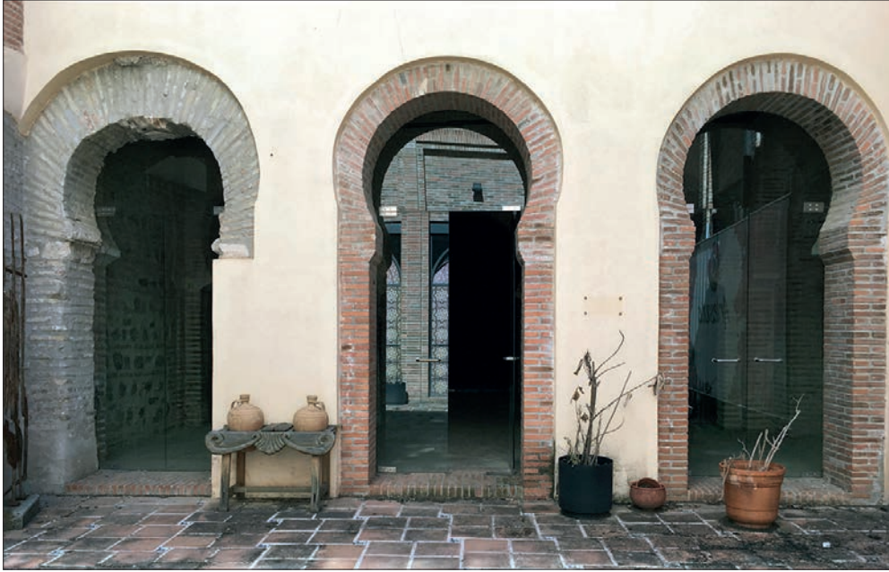
FIGURA 10: ASPECTO DE LA FACHADA ANTES DE LA INTERVENCIÓN DE 2020, CON LAS DOS MOCHETAS AÑADIDAS POR F. JURADO EN LA DÉCADA DE LOS 80 DEL SIGLO PASADO. ESTA RECREACIÓN HISTORICISTA HA DIFICULTADO LA LECTURA DE LAS FASES DESCRITAS EN ESTE ARTÍCULO
