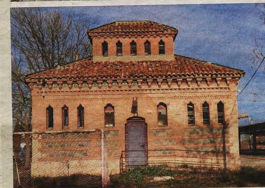
Proyectos de Clavería. Pabellón de retretes en la estación de Toledo (1913) y en la de Algodor (1920) Fotos de N. Clavería y Rafael del Cerro
