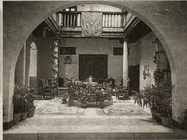
Vista del patio de la central de la calle de la Plata tras su rehabilitación en 1948. (Archivo Antonio Pareja)
