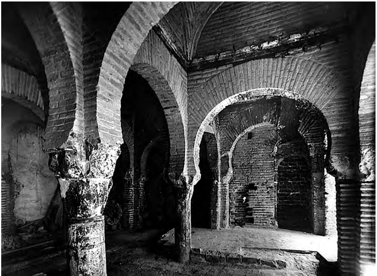
Fig. 7. Estado de la mezquita en 1958 y compartimentación interior del número 31 demolida, fachada norte. Detalle de la reconstrucción por Valcárcel de uno de los machones de ladrillo del interior de la fachada a Tornerías. (Casa Rodríguez, Biblioteca Digital de Castilla-La Mancha).
