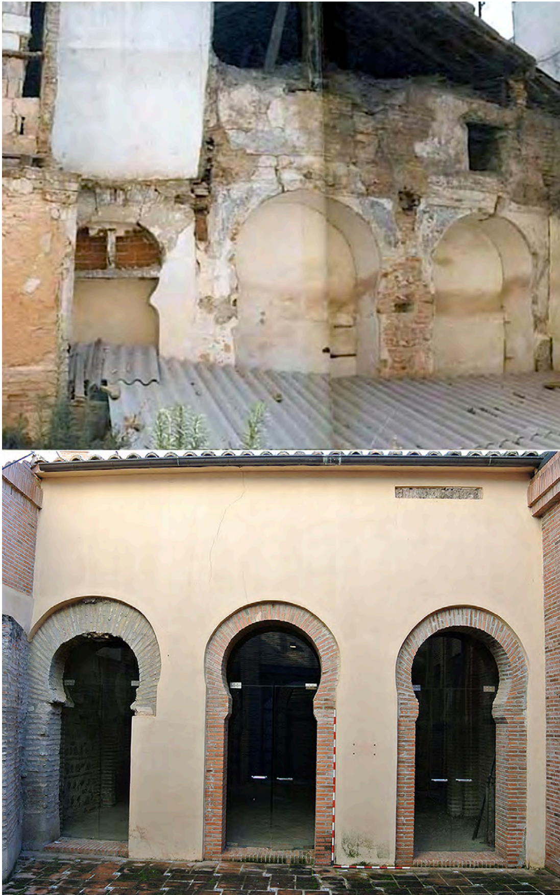
Fig. 10. Fachada de la mezquita tras la demolición de la casa adosada y fachada resultante tras la intervención de Jurado. (Fotos: F. Jurado y A. Ruiz Taboada).
