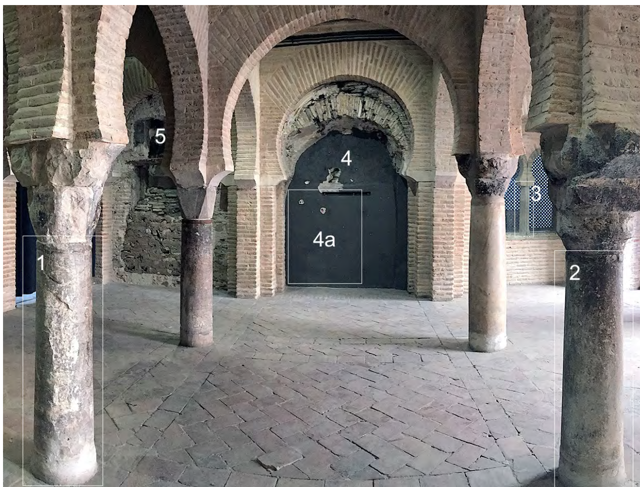
Fig. 2. Interior de la mezquita con los cipos reutilizados como fustes, 1, 2 y 3. El cipo número 2 conserva una inscripción vertical en cúfico, descubierta por el equipo de restauradoras de la empresa Alcaén, durante las obras de restauración de 2020. 3. Ventana geminada restaurada por Valcárcel. 4. Mihrab en la fachada sur. 4a Hueco de escalera tapiado. 5. Antigua chimenea en la bóveda sureste. (Foto: A. Ruiz Taboada).
