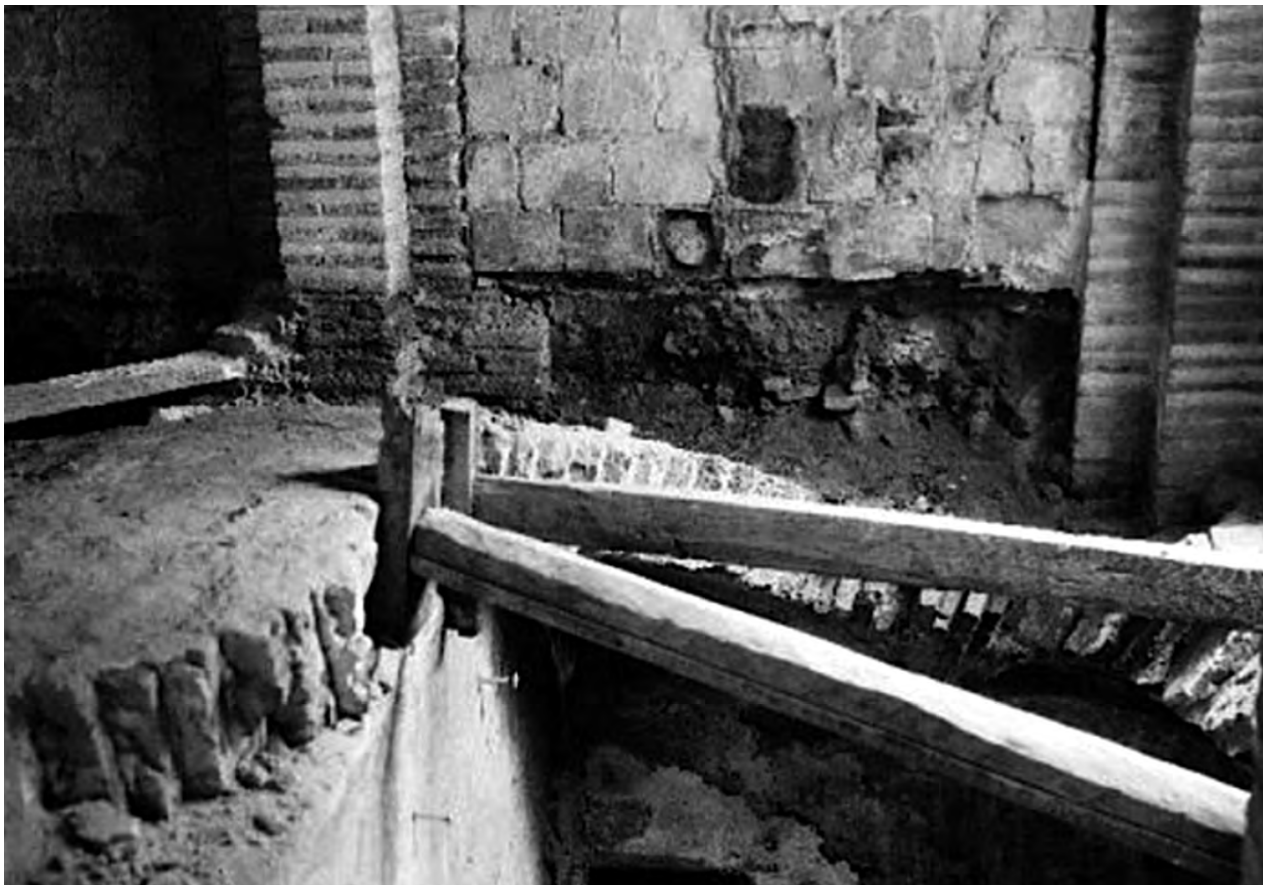
Fig. 9. Vista general de la bóveda suroeste de planta baja y muro sobre el que se apoyaba su clave antes de su demolición (Casa Rodríguez 1959, Biblioteca Digital de Castilla-La Mancha).
