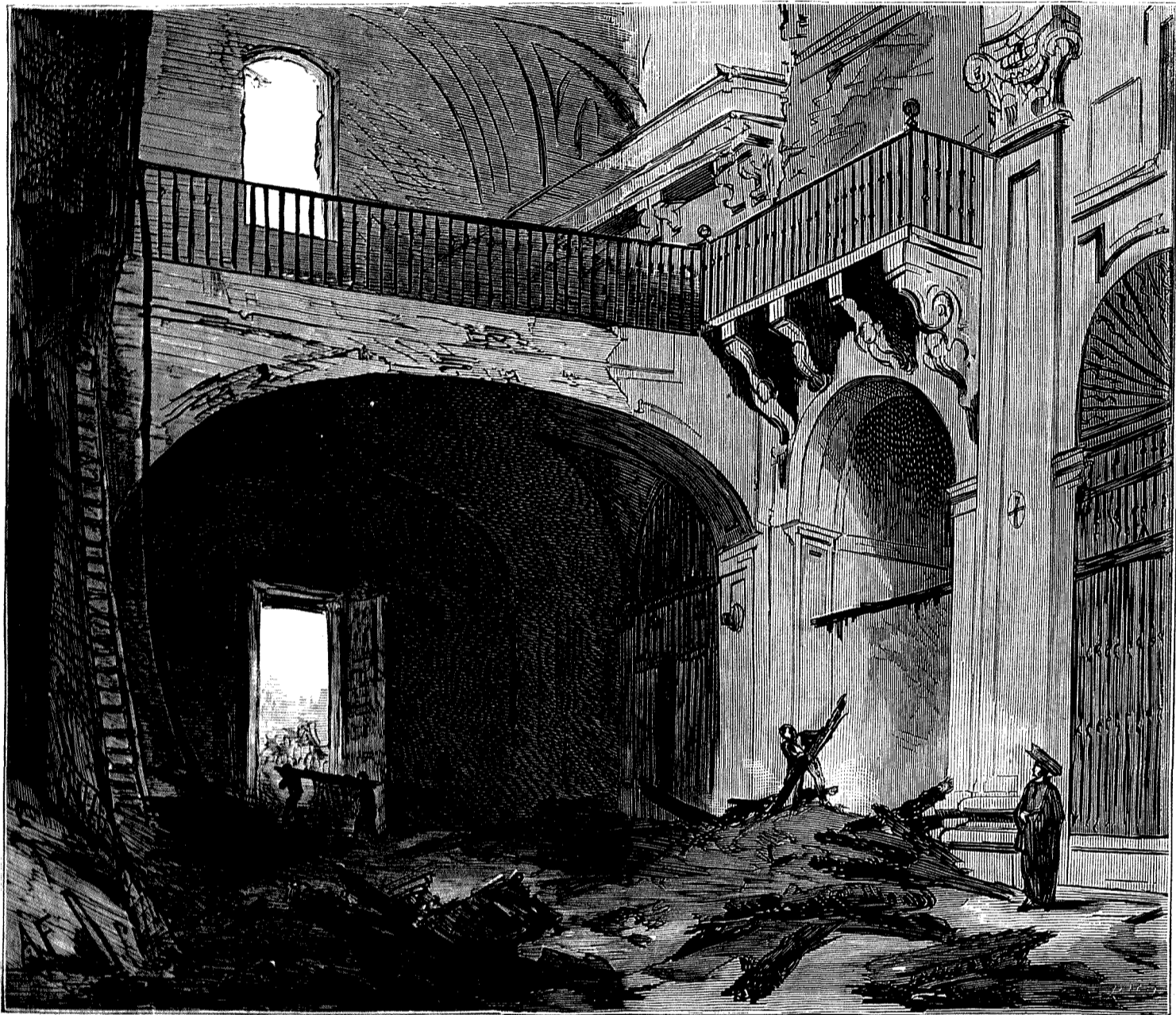
CORO DE LA IGLESIA DE SANTO TOMÁS DESPUES DEL INCENDIO.—(MADRID.)
