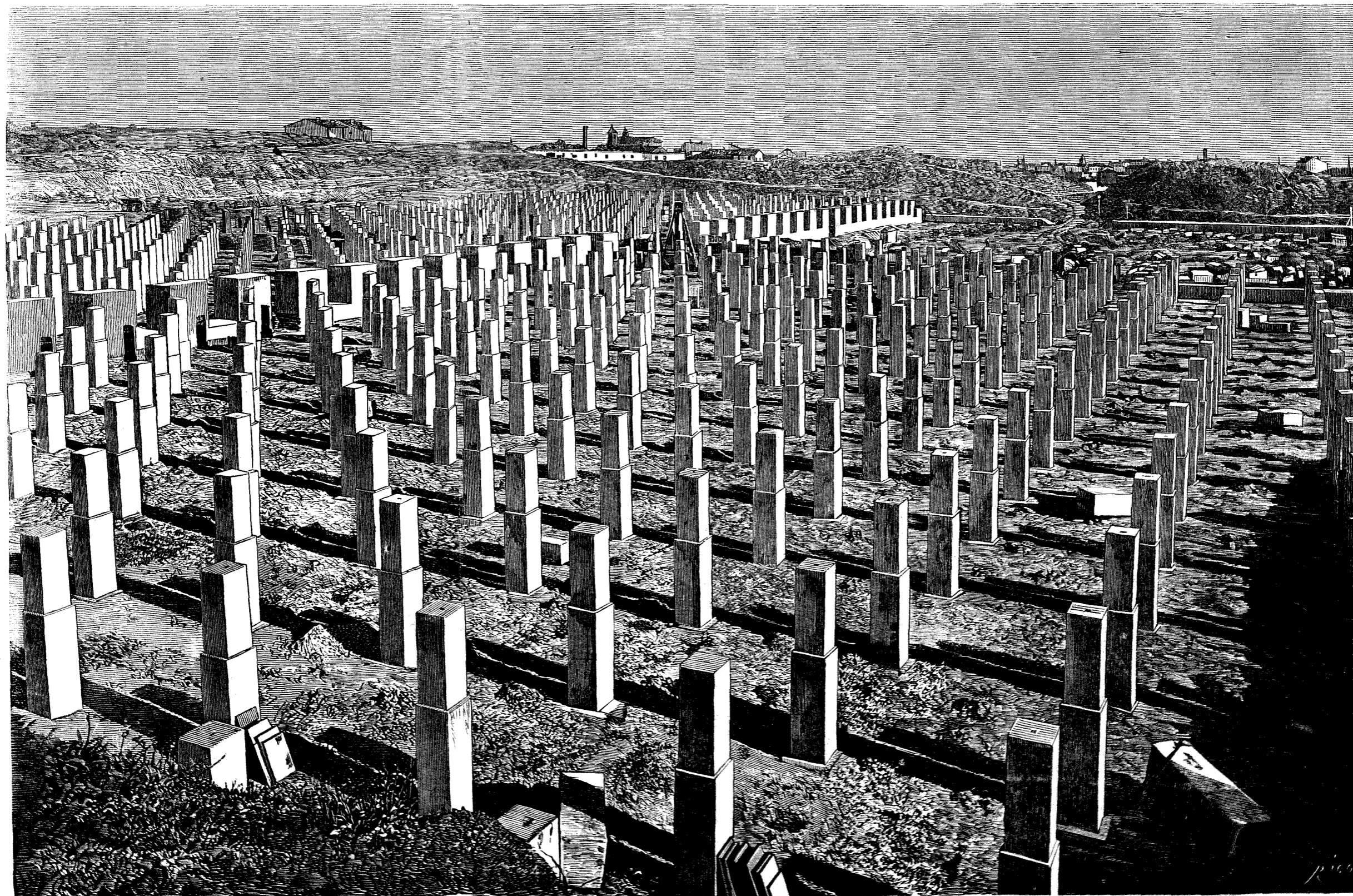
OBRAS PÚBLICAS EN MADRID.—NUEVO DEPÓSITO DE AGUAS DEL LOZOYA.
