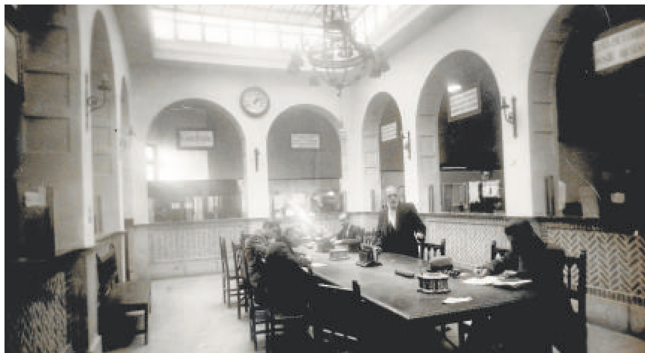
Interior de la definitiva Casa de Correos y Telégrafos en la calle de la Plata hacia 1933. Archivo Histórico Provincial. Foto Rodríguez
