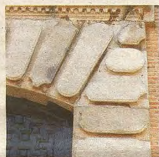
Detalle de la cantería barroca (R. del Cerro)
