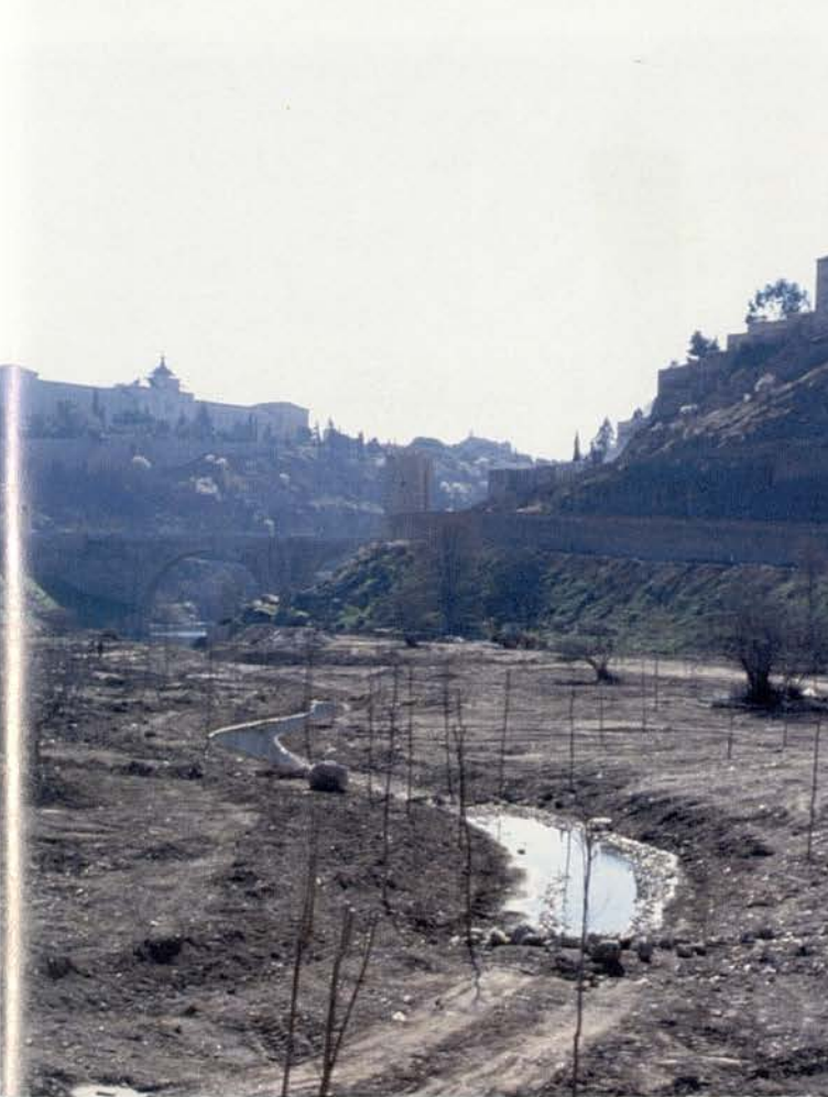
Arriba: El nuevo parque de Safont a poco de iniciarse las obras de acondicionamiento. Todo el entorno ha quedado remodelado con acierto.
