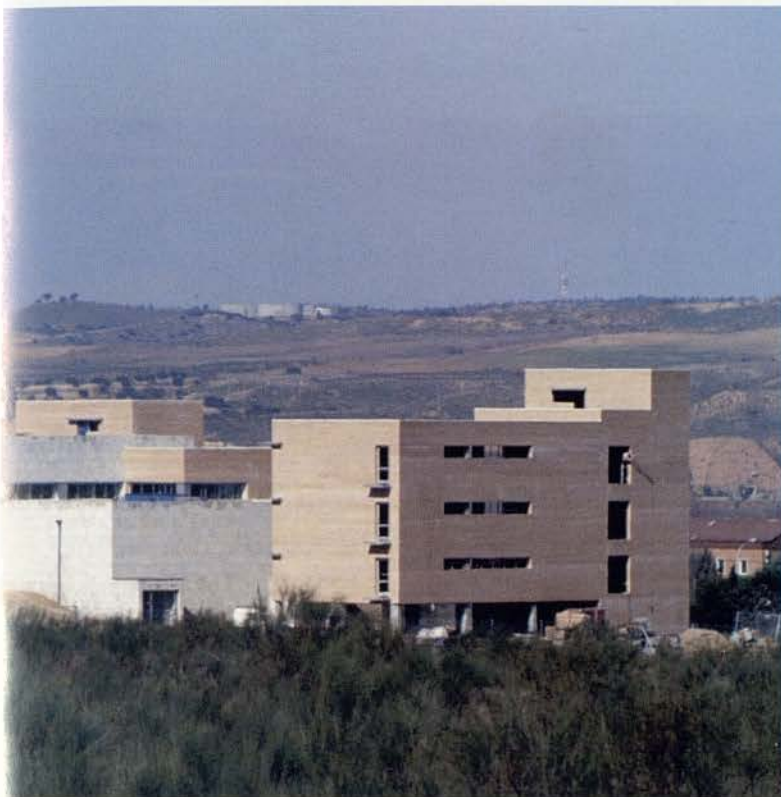
Escuela de Hostelería, una gran obra para un barrio que cada vez acoge mayor número de centros oficiales, de estudio y de investigación
