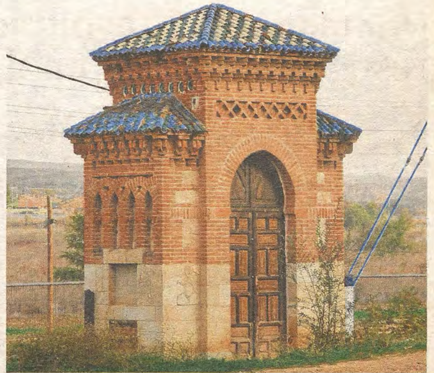
Transformador en la Estación de Ferrocarril
