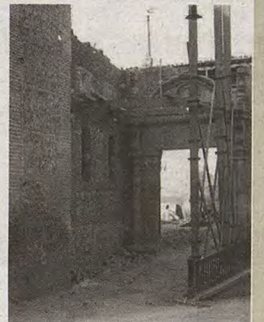
Obras de reforma en 1947. (Foto: Colección. J.L. Isabel Sánchez)
