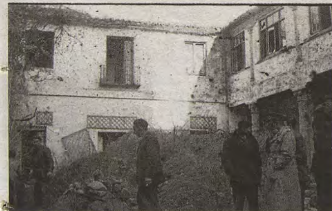
Aspecto del patio en 1947. Foto Col. J.L. Isabel Sánchez
