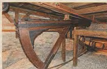
A la derecha, los técnicos comprobando el nivelado con el escenario. Abajo, la maquinaria de elevación en su posición habitual
