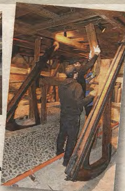
Tareas de afianzado tras la elevación del pavimento
