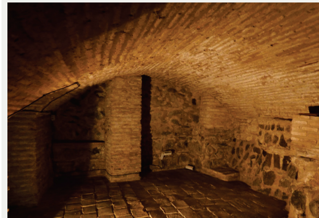
Galería de época medieval rescatada en la última rehabilitación (2017) del edificio que albergó el Hospital de San Pedro y el taller del pintor Luis Tristán
