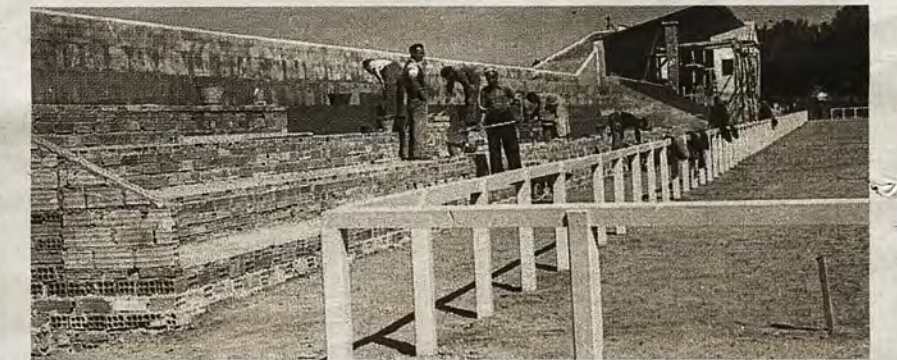
Obras de construcción del estadio Carlos III en la Fábrica de Armas en 1950. Foto. Archivo Municipal de Toledo. FA
