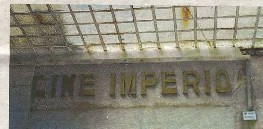
Detalle de la fachada antes de ser derribada en 1999
