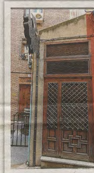
Antigua puerta de emergencia del patio de butacas del Cine Moderno. (FOTO: Rafael del Cerro)
