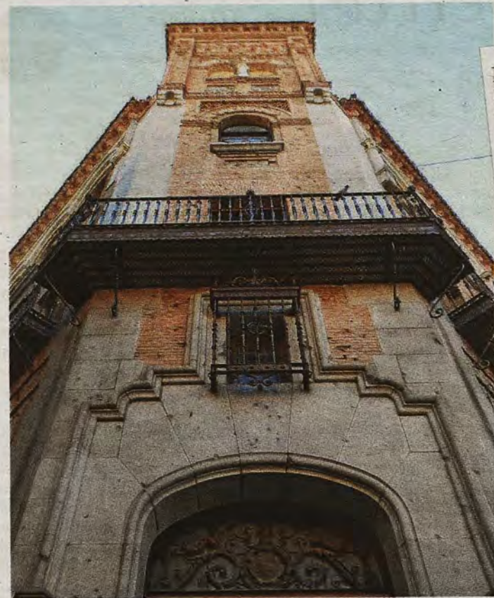
El edificio en 2016 Detalle de una fachada lateral
